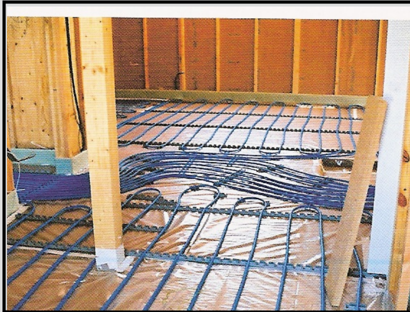
Impianto di riscaldamento a pavimento in un cantiere di una costruzione in legno con sistema costruttivo tipo "platform".
