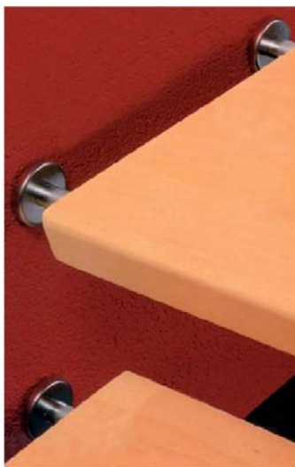
applicazione a muro dei perni in acciaio con rondella nei tasselli in neoprene
