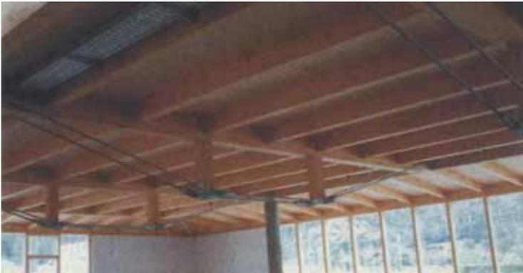
Solaio realizzato con travi lamellari a doppia orditura: si nota che la trave principale ha dimensioni limitate a causa della struttura tesa posta all'intradosso che consente l'interposizione di due appoggi intermedi
