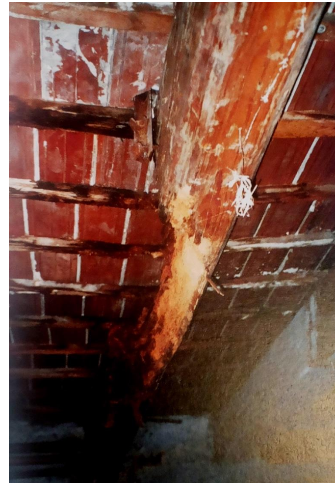
Attacco di muffe, funghi cromogeni e insetti, causato da un infiltrazione d'acqua.
