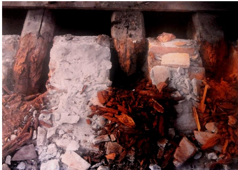
Esempio di attacco di carie bruna sulle teste di travi in corrispondenza degli appoggi.
